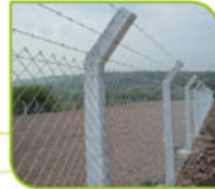
h:300 cm Eğri Beton Direkli Galvaniz Örgü Tel Üzeri Dikenli Tel Uygulama
