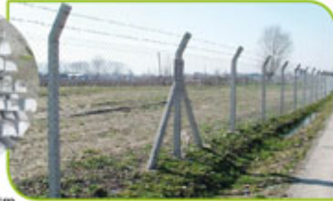
h:300 cm Eğri Beton Direkli Galvaniz Örgü Tel Üzeri Dikenli Tel Uygulama
