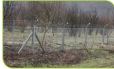
h:240 cm Beton Direkli Galvaniz Örgü Tel Üzeri Dikenli Tel Uygulama
